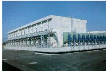
Torre de refrigeración de hormigón prefabricado Torre de enfriamiento FRP de bajo ruido
