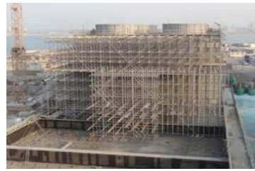
Torre de refrigeración de 22 celdas en construcción en Qatar
