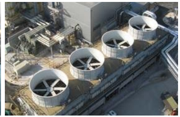
Torre de refrigeración de madera para una central eléctrica
