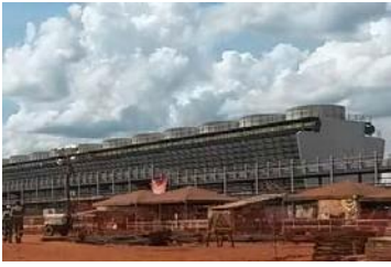
Instalación de FRP crossflow en Brasil Torre de refrigeración híbrida húmeda/seca
