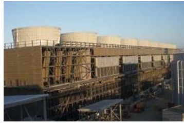
Instalación de FRP crossflow en Brasil Torre de refrigeración híbrida húmeda/seca
